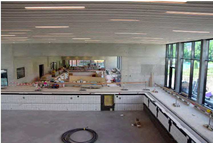
Auf einen Blick: die kompakte Anordnung des Innenraums, die räumliche Deckengestaltung sowie die «Matrizen» in den Sichtbetonwänden des Hallenbades in Altstätten.
