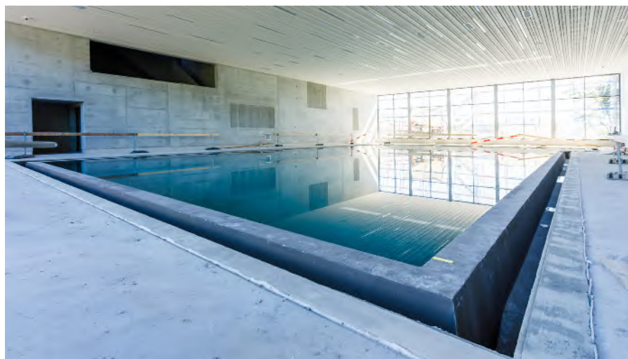
Das neue 25-Meter-Schwimmbecken mit 5 Bahnen.
