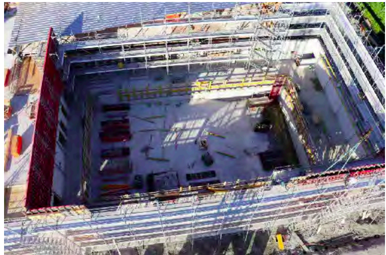
Der Erweiterungsbau für das neue 25-Meter-Schwimmbecken.
