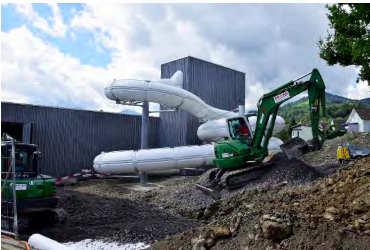
Arbeiten an den Aussenanlagen im Sommer um den Treppenturm und um die 80 Meter lange Rutsche herum.
