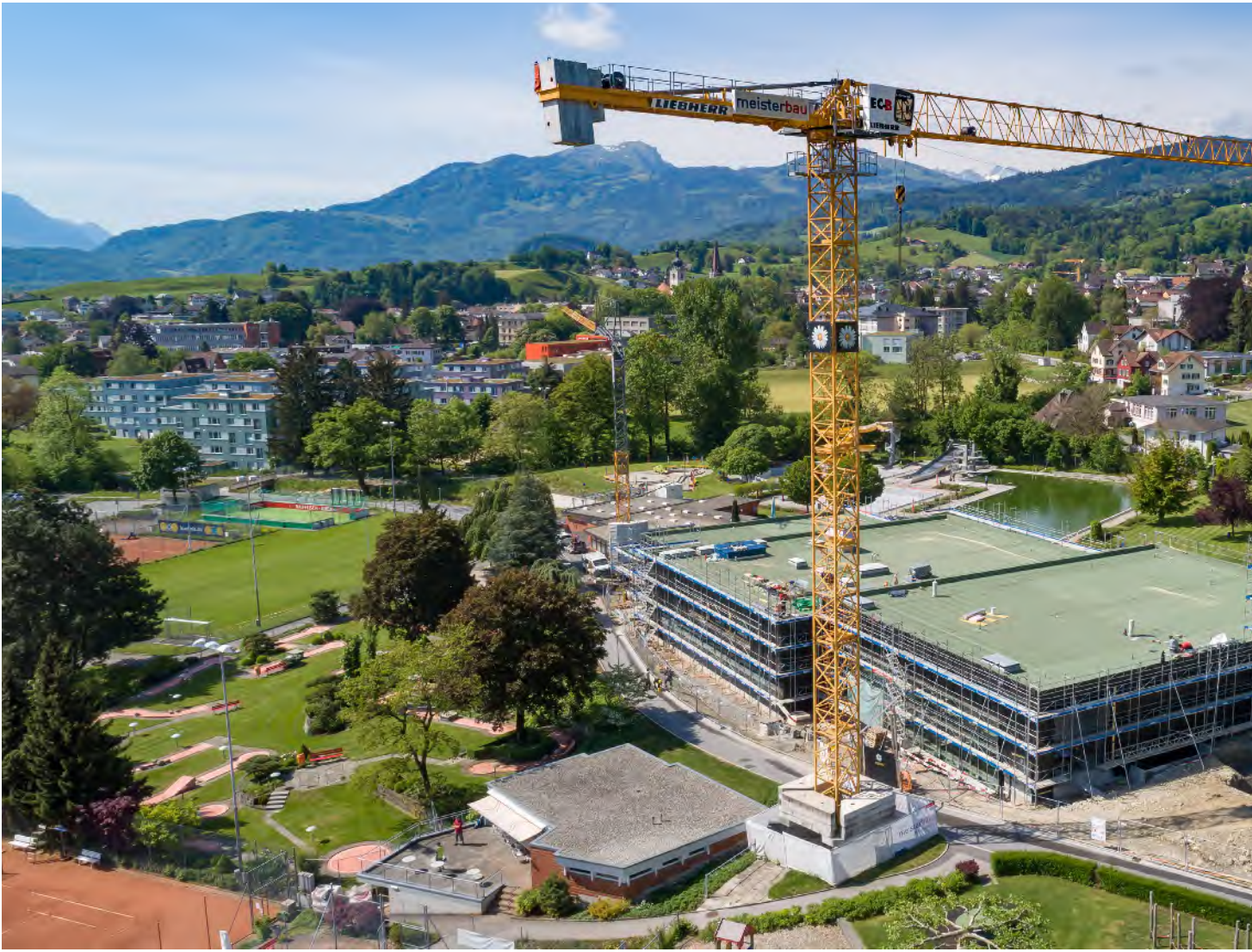
Ersatzneubau «aquaRii Bad Oberes Rheintal» in Altstätten während der Rohbauarbeiten.
